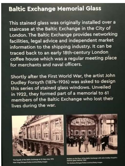
Figure 4. Old photos of baltic exchange (No. 30) 图 4. 波罗的海交易所旧照(No. 30)
