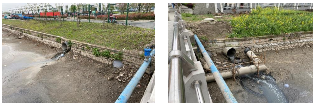
Figure 2. Sewage outlet of Central River 图 2. 中心河排污口情况
