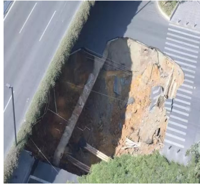
广州地铁地面塌陷
