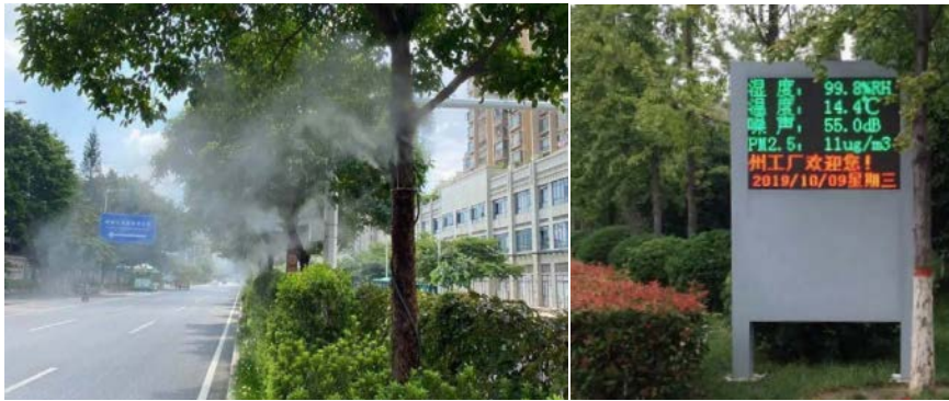
Figure 4. Dust suppression design and fogging system 图 4. 用于降尘的雾森装置和环境检测系统
