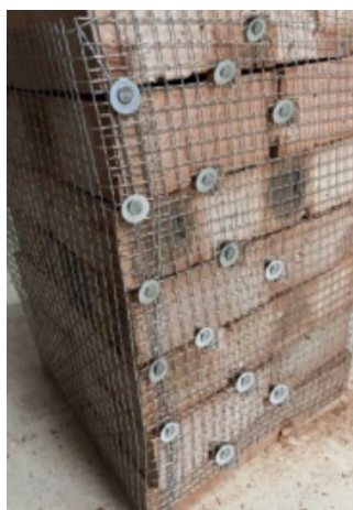
Figure 3. Reinforce damaged URMs with GFOR 图 3. 使用 GFOR 加固受损的 URMs
