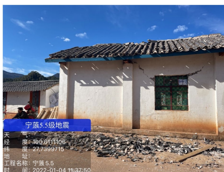
(b) 砌体结构地震灾害图
