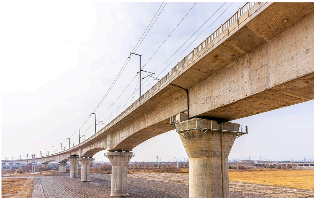
Figure 4. Elevated bridge and circular pile structure 图 4. 高架桥梁及圆形墩柱结构
