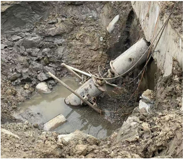
Figure 6. On-site static load test photos 图 6. 现场静载试验照片
