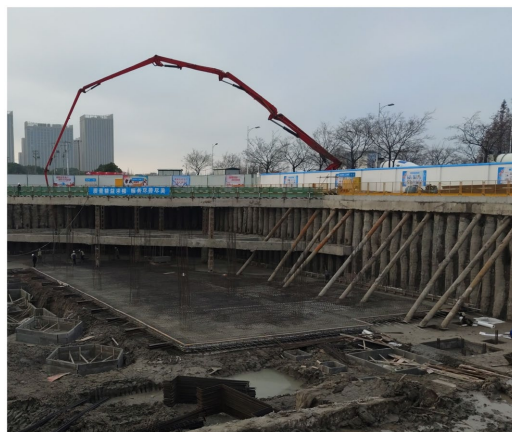
Figure 10. Photos of foundation pit excavation site 图 10. 基坑开挖现场照片
