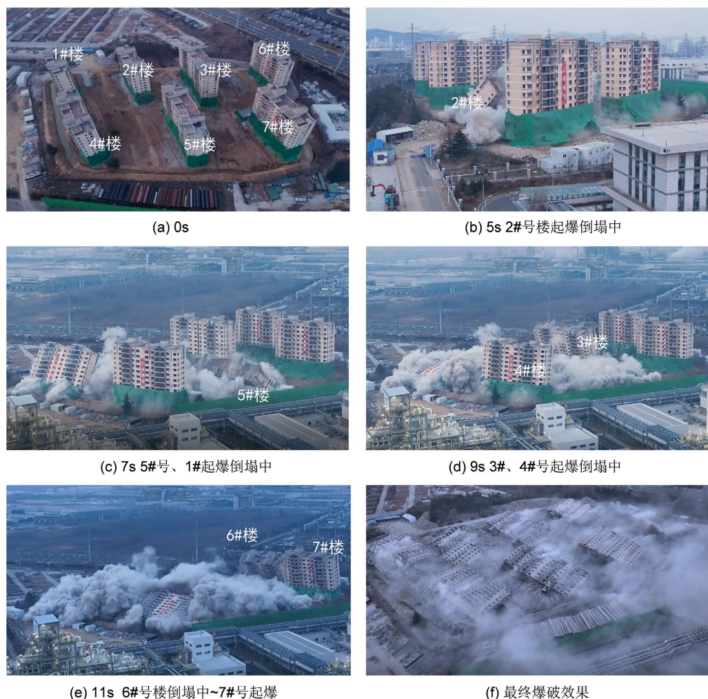
Figure 12. Blasting process and effect 图 12. 爆破过程和效果
