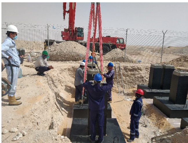
Figure 4. Foundation installation 图 4. 基础吊装就位
