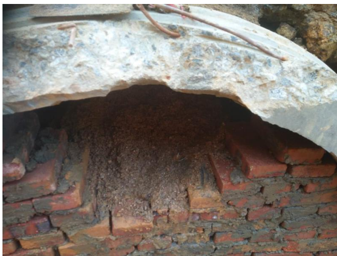
Figure 4. Sand blowing site 图 4. 吹砂现场
