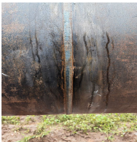
焊缝外观检查
