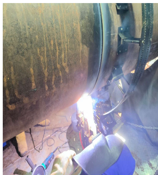
热焊焊缝检查
