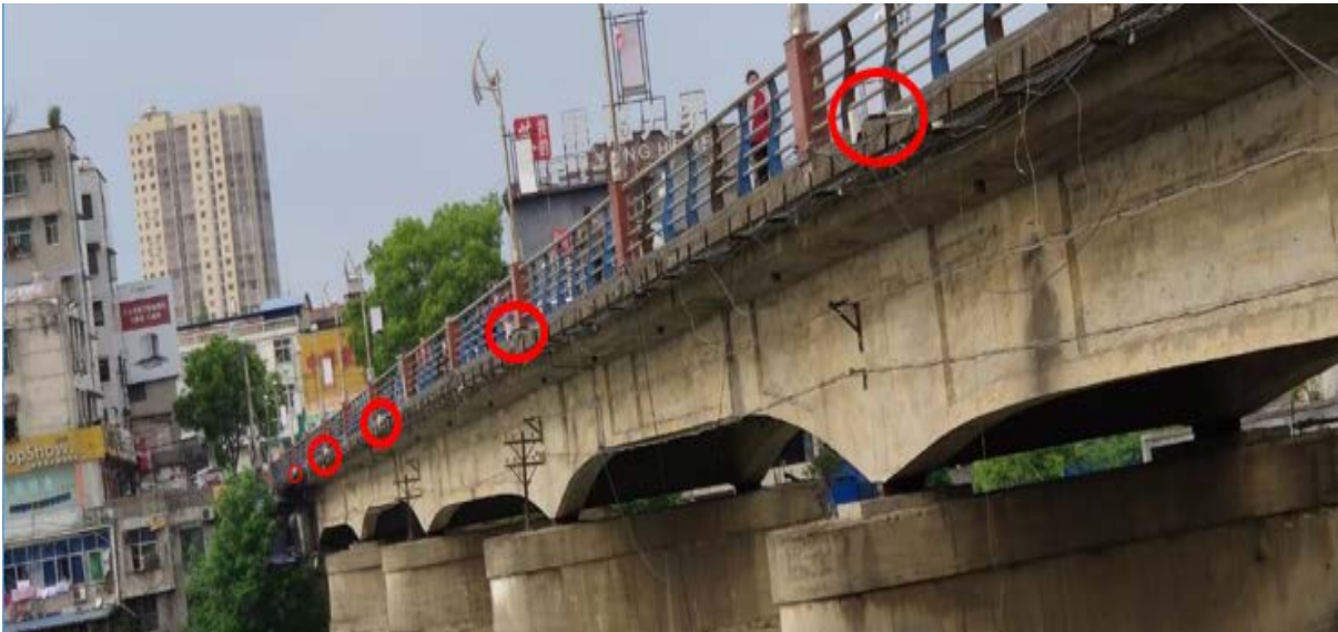
1#测量点位 2#测量点位 3#测量点位 4#测量点位 5#测量点位
