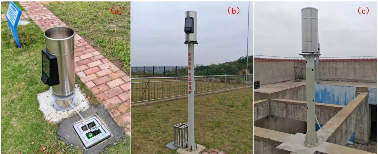
图 1. 不同高度雨量计安装图。(a) 地面 0.7 m 雨量计；(b) 2.5 m 高杆雨量计；(c) 屋顶雨量计
