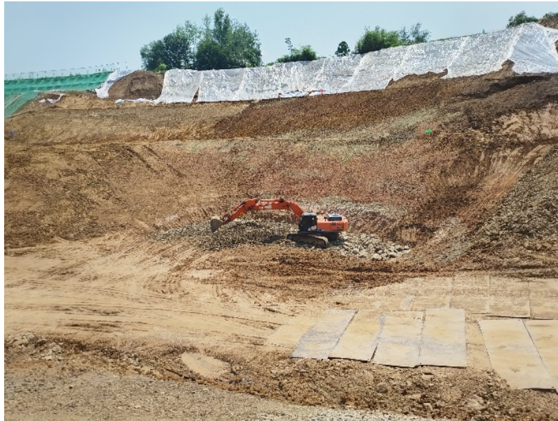
Figure 4. Landslide cleaning 图 4. 滑坡体清理
