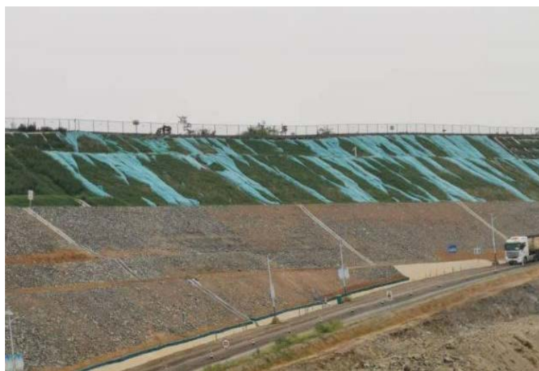
Figure 13. Slope reinforcement project 图 13. 坡面加固工程
