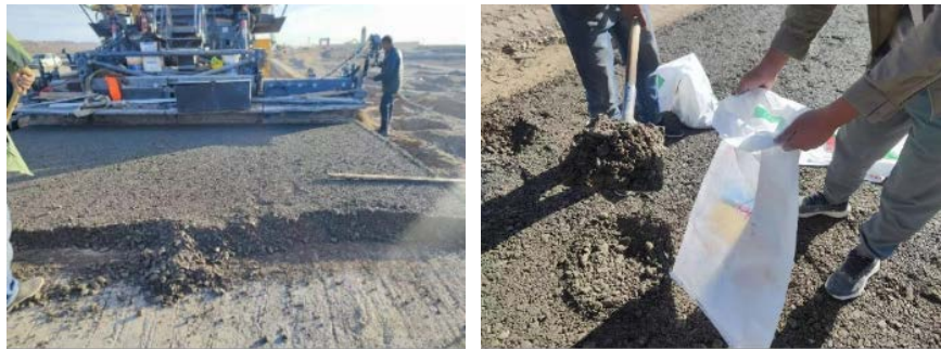
Figure 12. On-site sampling diagram 图 12. 现场取样图
