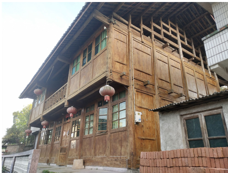
(b) 湖南省娄底市新化县正龙古村(木板隔墙、瓦作屋面)
