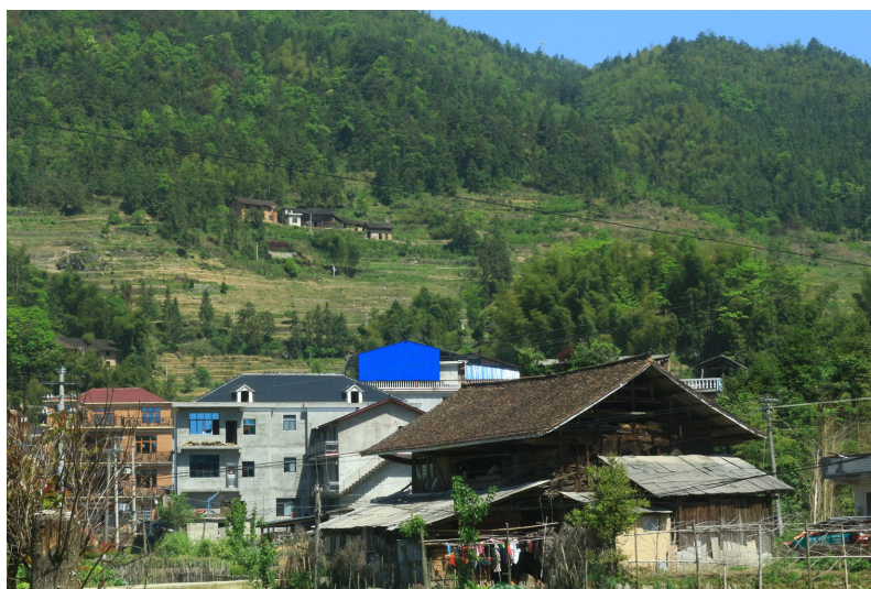
(a) 湖南省娄底市新化县楼下村(生土夯筑的土坯墙、瓦作屋面)
