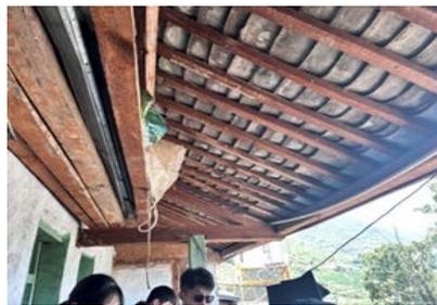
房顶用木条搭成三角体，用瓦片封顶具有一定的倾斜程度
