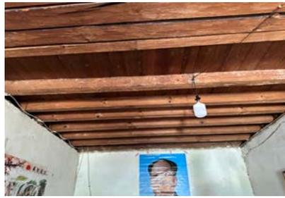
楼层之间用较整齐的木头做梁，并用混凝土封顶
