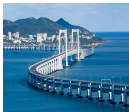
Figure 9. Xinghai Bay Bridge 图 9. 星海大桥
